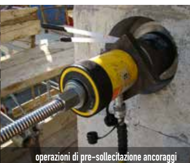
incatenamenti longitudinali esistenti
