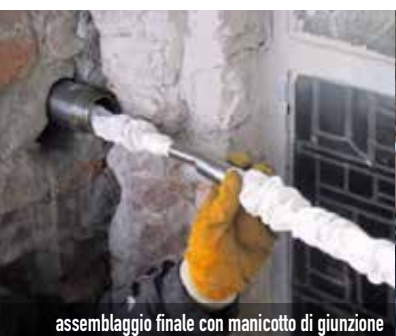
inserimento ancoraggio all'interno del tubo di protezione
