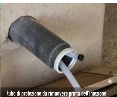
inserimento ancoraggio all'interno del tubo di protezione
