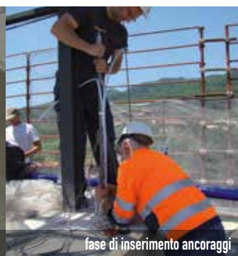
ancoraggi strumentati
